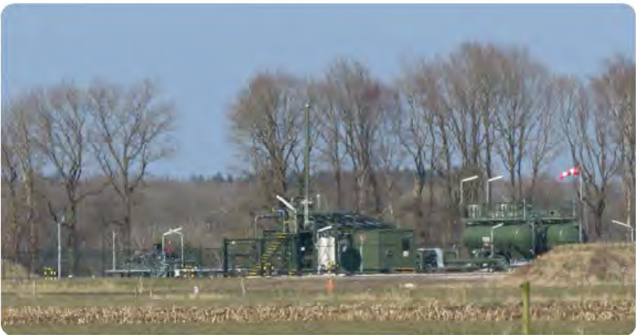
Voorbeeld van een mijnbouwlocatie van Vermilion
