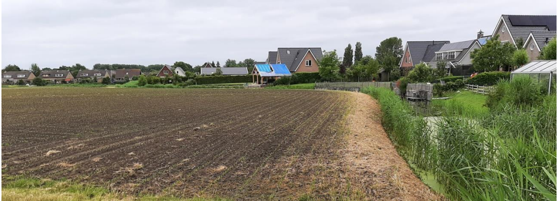
Zicht op Oude Melkvaart en de achtertuinen van de woningen aan De Wijting.
